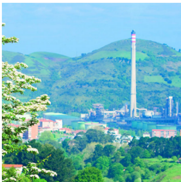
Ilustración 3. Ilustración de la refinería de Petronor. Fuente: http://petronor.eus/es/refineria/ .
